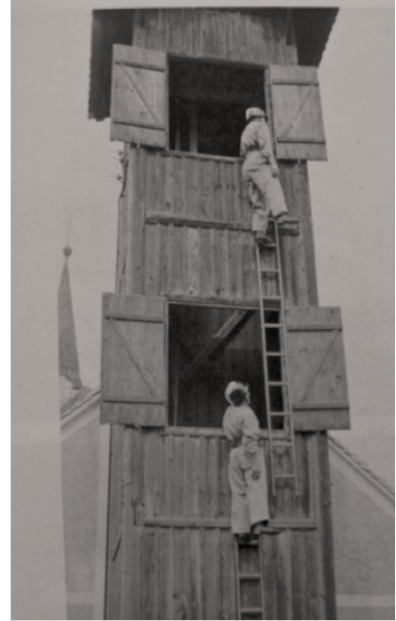
60er Jahre Eine Steigerübung am Steigerturm.
